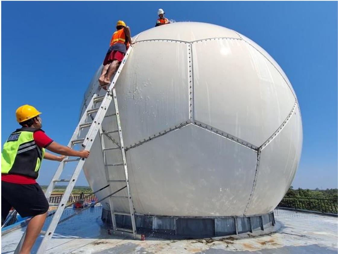
**Gambar 38 Kegiatan Pemeliharaan Radome Radar Cuaca Sintang di Stasiun Meteorologi Tebelian**
